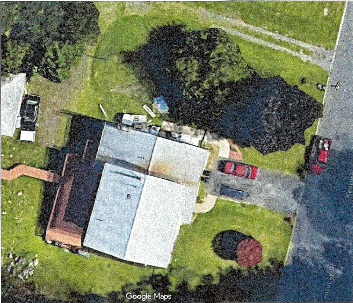
2 Existing Driveway Condition Scale: N.T.S.
